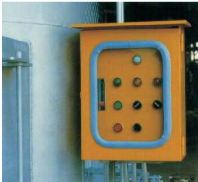
防水式的配電箱適合室外使用
